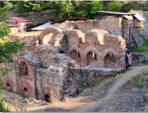
Römische Bäderruinen in Bansko
