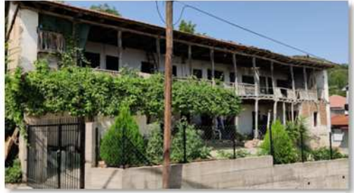
Traditionelles Wohnhaus: Oben Schlafräume und Veranda.
